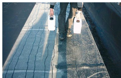
incollatura a strisce di RESITRIX classic con colla PU-LMF-02
