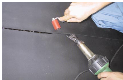
saldatura dei giunti con apparecchio a mano per tutti i collegamenti e angoli
