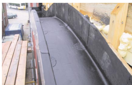
formazione di un angolo esterno con pezzi separati di RESITRIX SK o SK W
