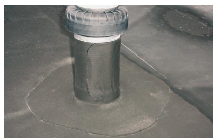
sigillatura di una ventilazione con pezzi separati di RESITRIX SK o SK W
