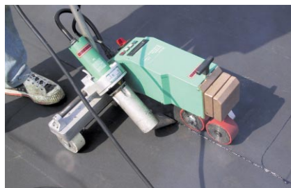
saldatura dei giunti con apparecchio, tipo Leister - Varimat, per tutti i giunti di libero accesso
