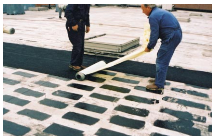
posa di RESITRIX SK risp. SK W dopo un trattamento a punti con primer FG 35
